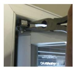
Figure 12 Disengage Hinge Pin
